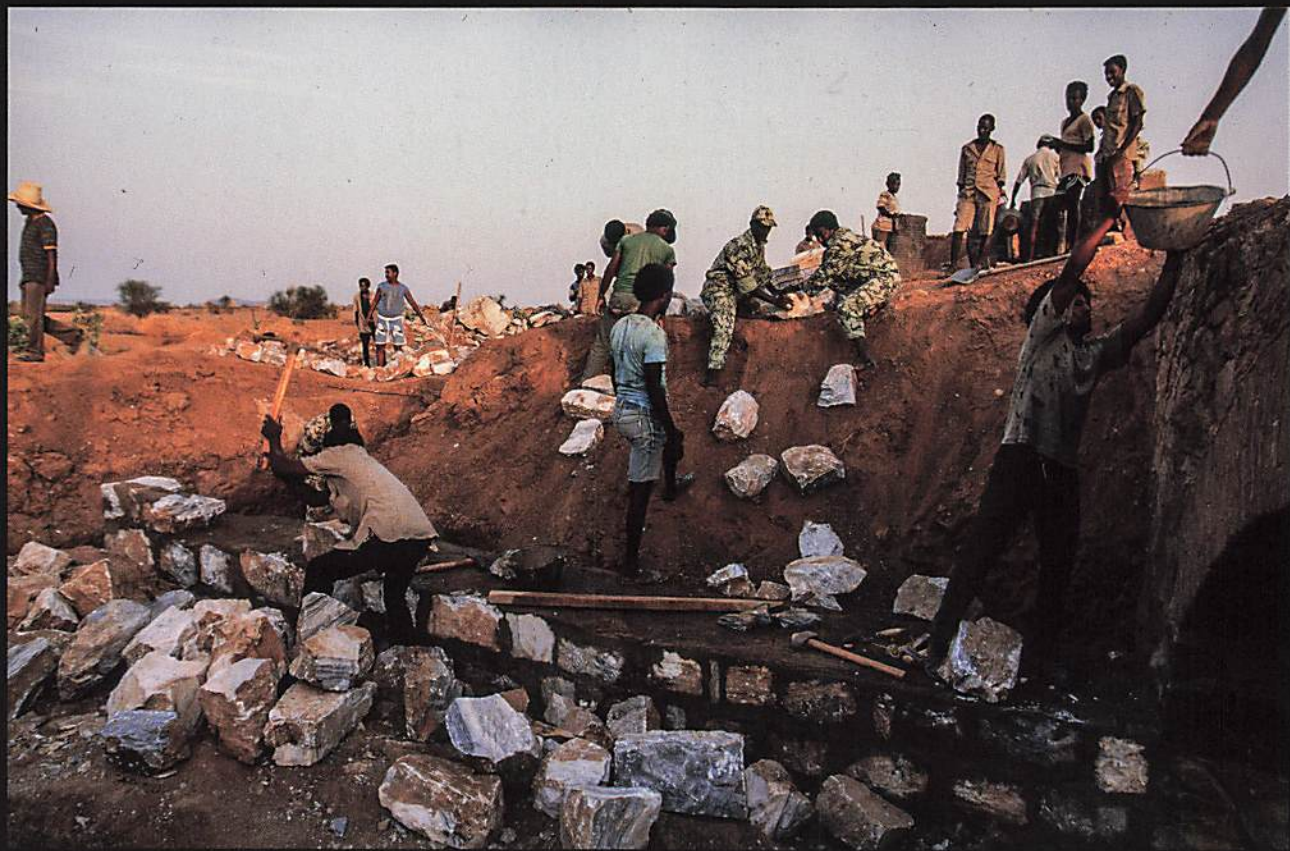
開發:道路建設 Development : Road construction
